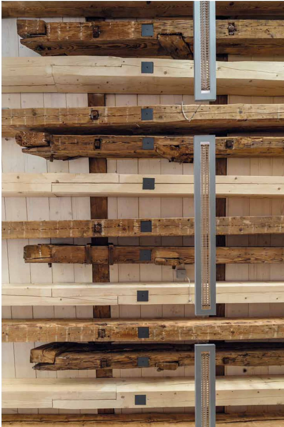
Musiksaal Deckenuntersicht mit Hölzern aus verschiedenen Zeiten
