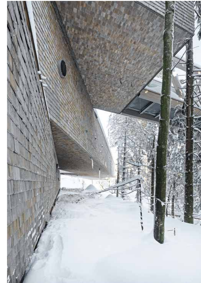
Untersicht Skywalk und Riegel B
