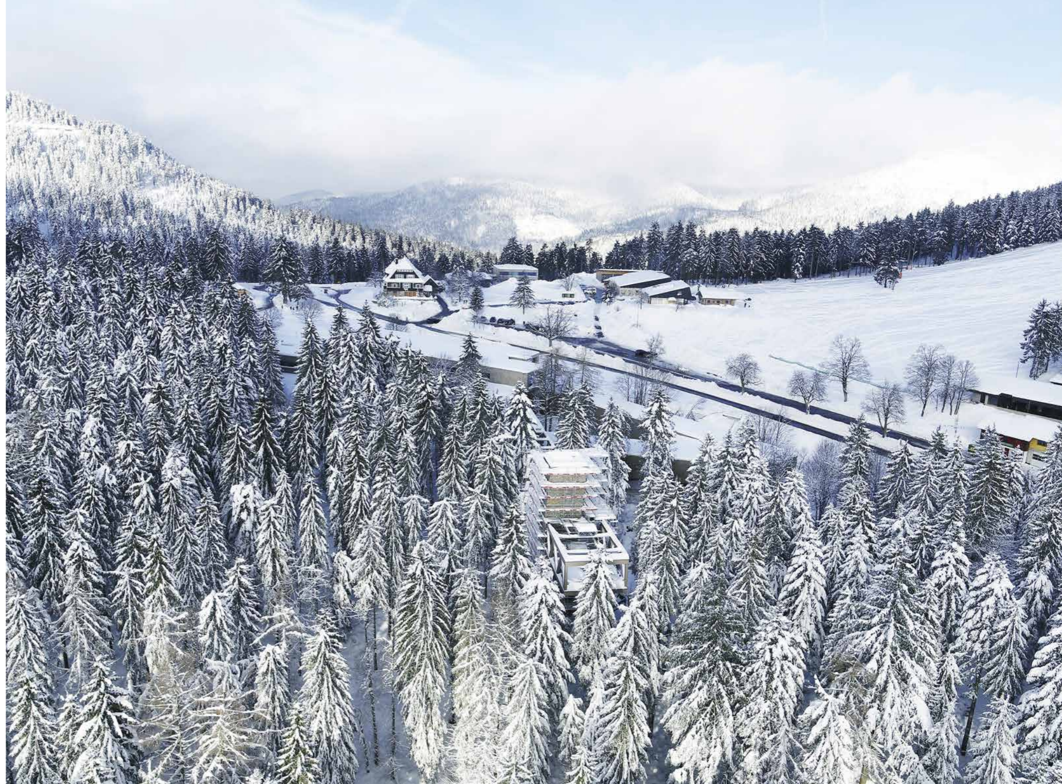
Ruhestein Ansicht von Südwesten
