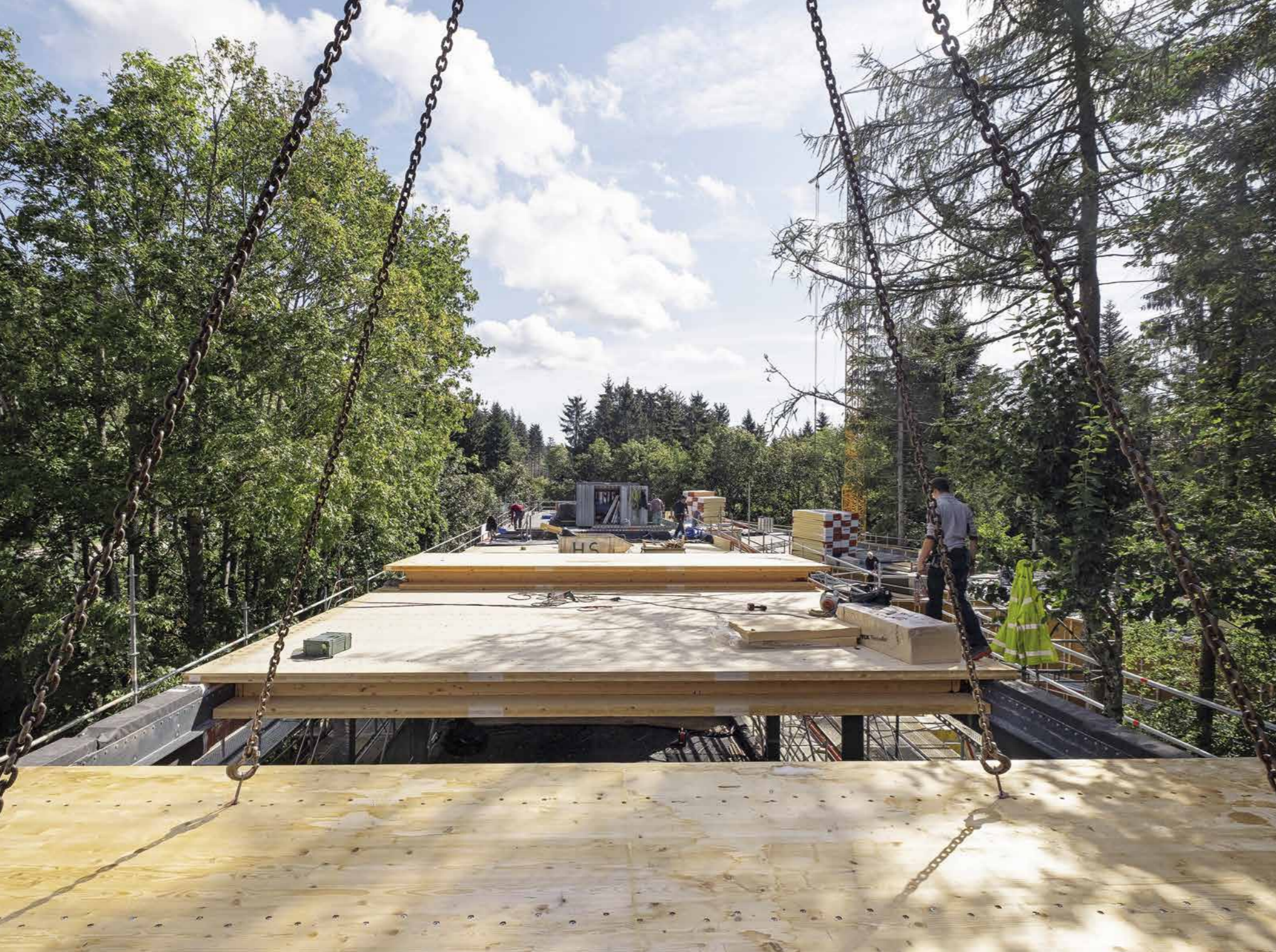
Montage Deckenelemente Erhalt der Bäume
