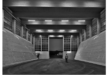
NEUBAU SALZLAGERHALLE GEISLINGEN
