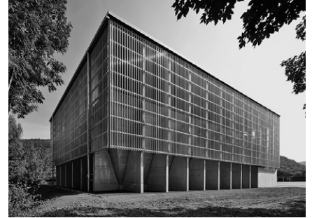
NEUBAU SALZLAGERHALLE GEISLINGEN
