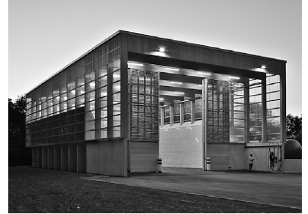
NEUBAU SALZLAGERHALLE GEISLINGEN
