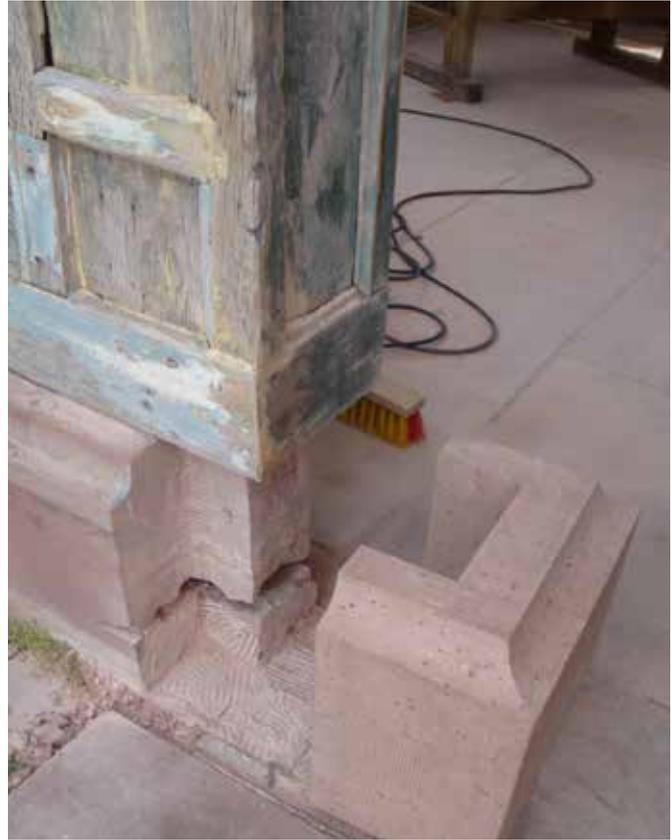
Herstellung einer Aussparung zum Einbau einer Sockelsandsteinverierung
