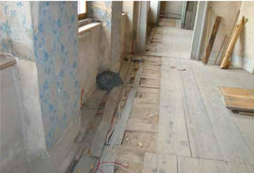
Die Tischlerarbeiten betrafen hauptsächlich das Öffnen und Schließen der Fußböden und Wandvertäfelungen vor und nach erfolgter Installation sowie Zuarbeiten für den Elektriker für Bohrungen, Ausklinkungen und Durchlässe. Darüber hinaus waren historische Türen zum Treppenraum in rauchdichter Ausführung umzurüsten und eine zweiflügelige Tür zum Finanzamt durch eine Brandschutztür zu ersetzen.
