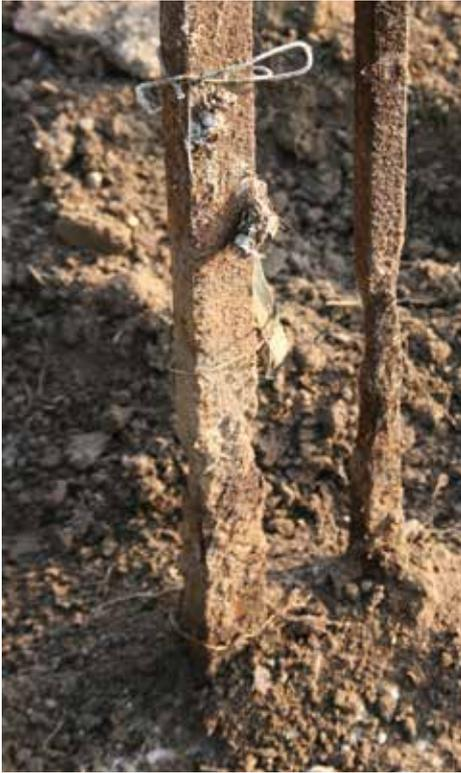
Fußpunkt der eisernen Stützkonstruktion vor der Sanierung
