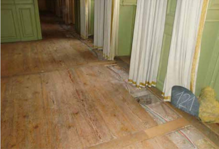
Aufgenommene Fußbodenbretter zur Verlegung von Stromkabeln
