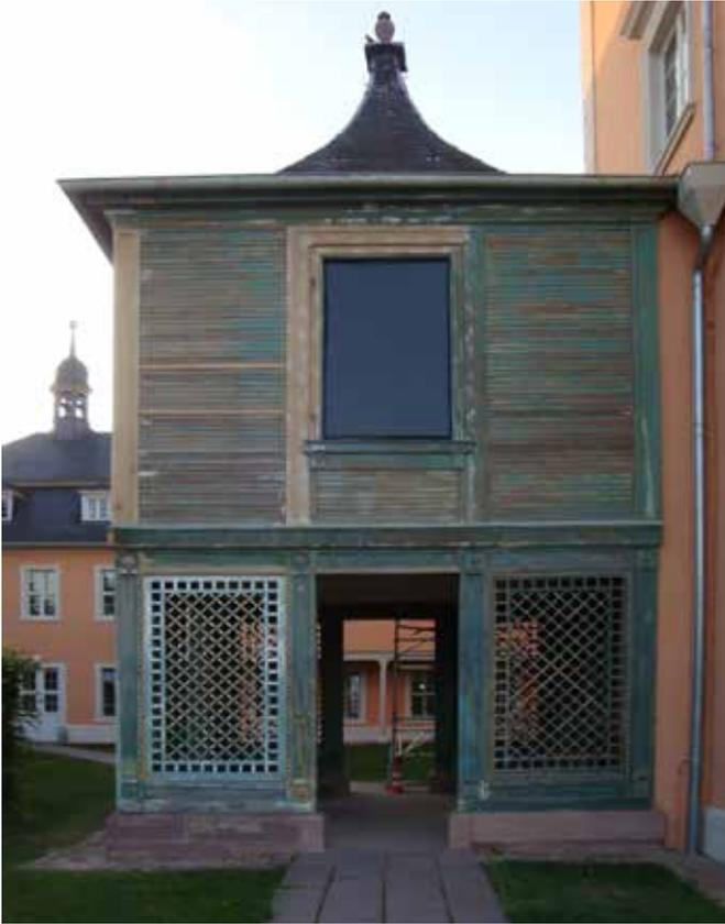
Fassade nach Austausch der beschädigten Holzteile
