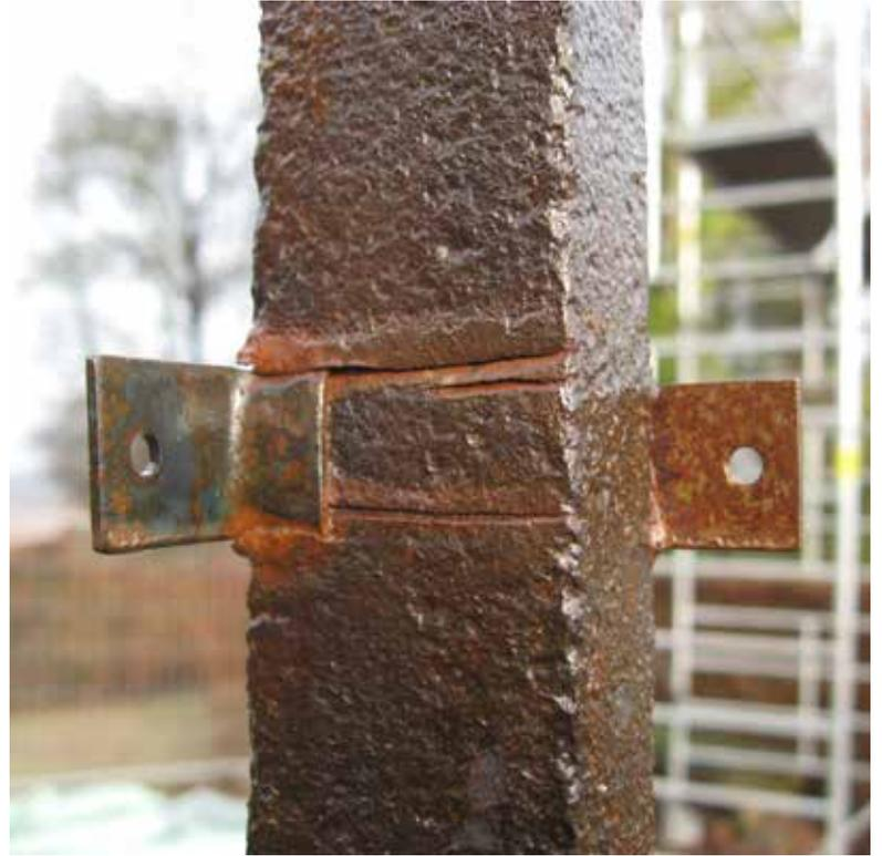
Befestigungsdetail für die Holzkonstruktion nach der Sanierung
