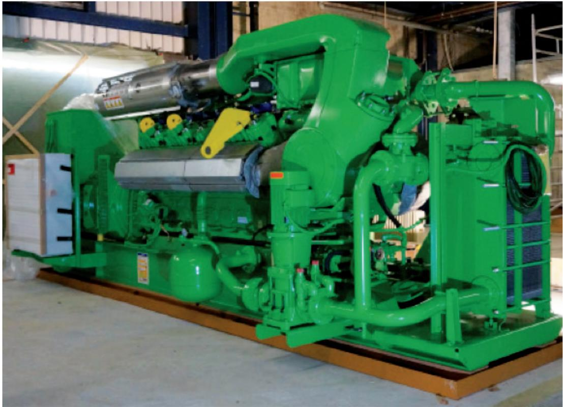
*Eine von zwei BHKW-Modulen des Heizkraftwerks der Universität Konstanz mit ca. 1,2 MW elektrischer Leistung*
