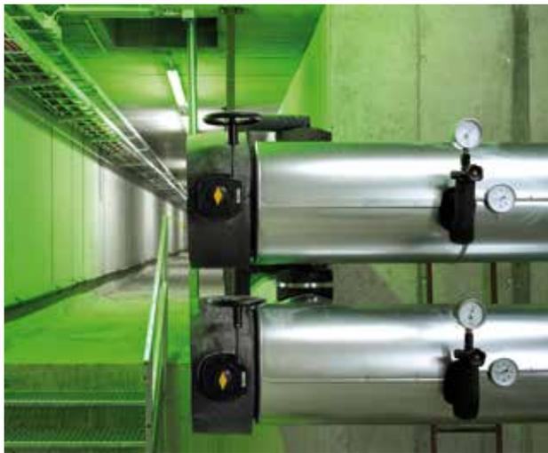
*Für den Betrieb des Großrechners sind zusätzlich vier Megawatt Strom und Kälte nötig. Bei der Kühlung wurde auf eine energiesparende Lösung gesetzt. Die Abwärme wird zu einem Großteil über freie Kühlung abgeführt. Investition 11 Mio. Euro*
