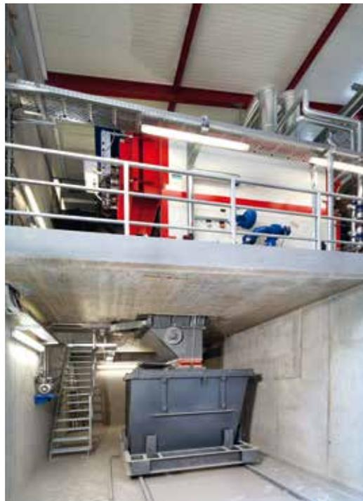
*Justizvollzugsanstalt Rottenburg: Einbau einer Holzhackschnitzel-Heizungsanlage und eines Blockheizkraftwerks mit einer Gesamtleistung von 1.200 kW sowie zwei Spitzenkessel mit 2.500 kW Heizleistung. Investition 3,74 Mio. Euro*
