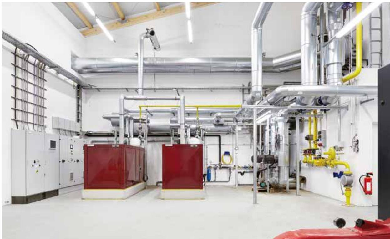
*Justizvollzugsanstalt Adelsheim, Erneuerung der Heizzentrale, Einbau eines Blockheizkraftwerks mit Holzhackschnitzel- und Gaskessel*
