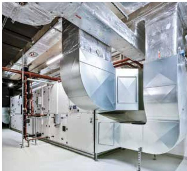
*Helmholtz-Institut Ulm, Neubau des Forschungs- und Laborgebäudes für Elektrochemische Energiespeicherung, kompakte Gebäudegeometrie und Wärmedämmung mit Unterschreitung der EnEV 2009 um 35 Prozent zur Minimierung der Wärmeverluste, Wärmerückgewinnung bei der Laborlüftung und Photovoltaik*
