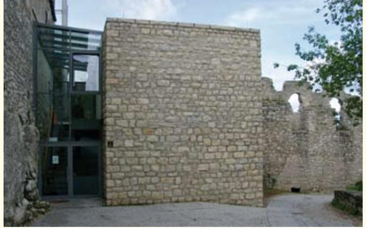
Der Erweiterungsbau für die Burggaststätte Hohenneuffen wurde mit dem für die Burg charakteristischen Kalkstein verkleidet. Bestandteil der Maßnahme war die Errichtung einer neuen Holzpellets-Heizzentrale.
