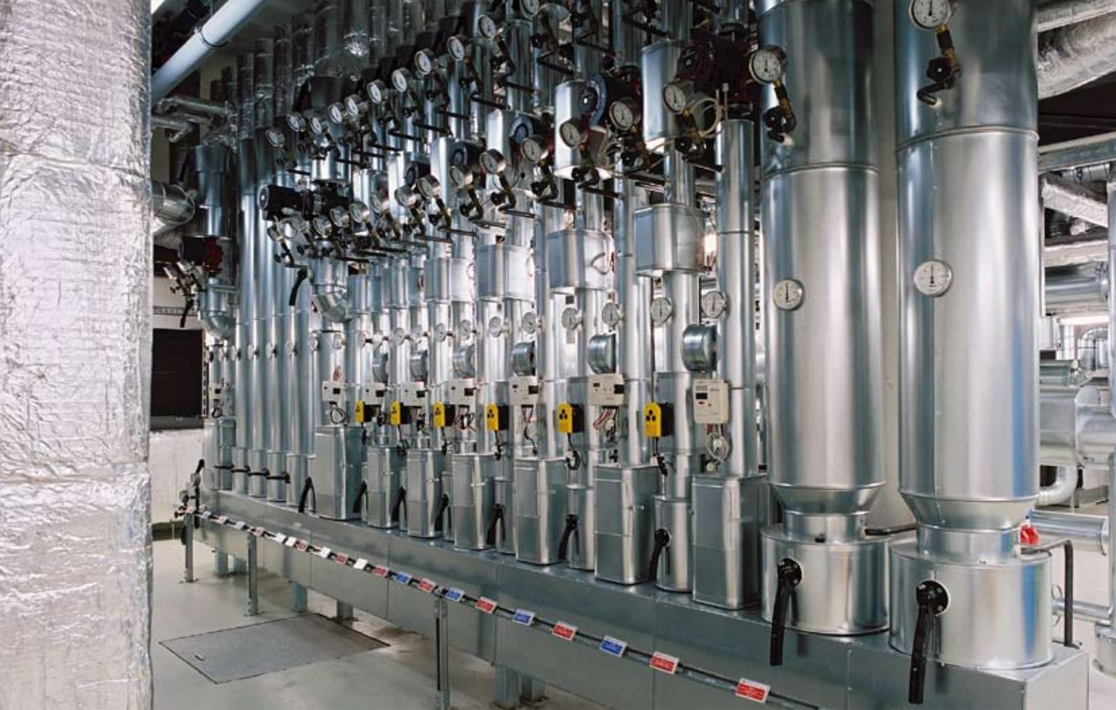
Zentrum für Biochemie und Molekulare Zellforschung, Universität Freiburg: Zentrale Wärmerückgewinnungsanlagen mit adiabater Fortluftkühlung sorgen ebenso wie dezentrale Umluftkühler, die raumbedarfsgerecht geregelt werden, für einen energiesparenden Betrieb.
