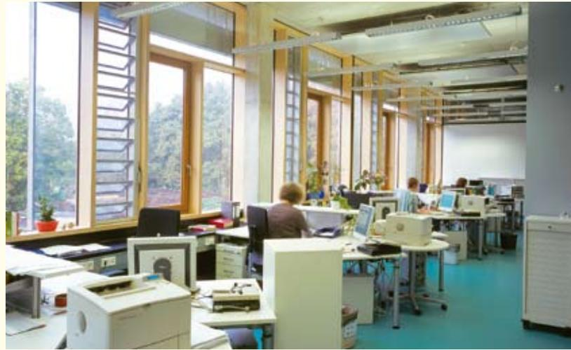
*Neubau Institut für Pathologie, Universitätsklinikum Freiburg: Im Sommer dringt durch spezielle Fensteröffnungen kühle Nachtluft ein. Im Winter erfolgt eine passive Sonnenenergienutzung. Beides wird in den massiven Bauteilen gespeichert und sorgt für ein angenehmes Raumklima.*
