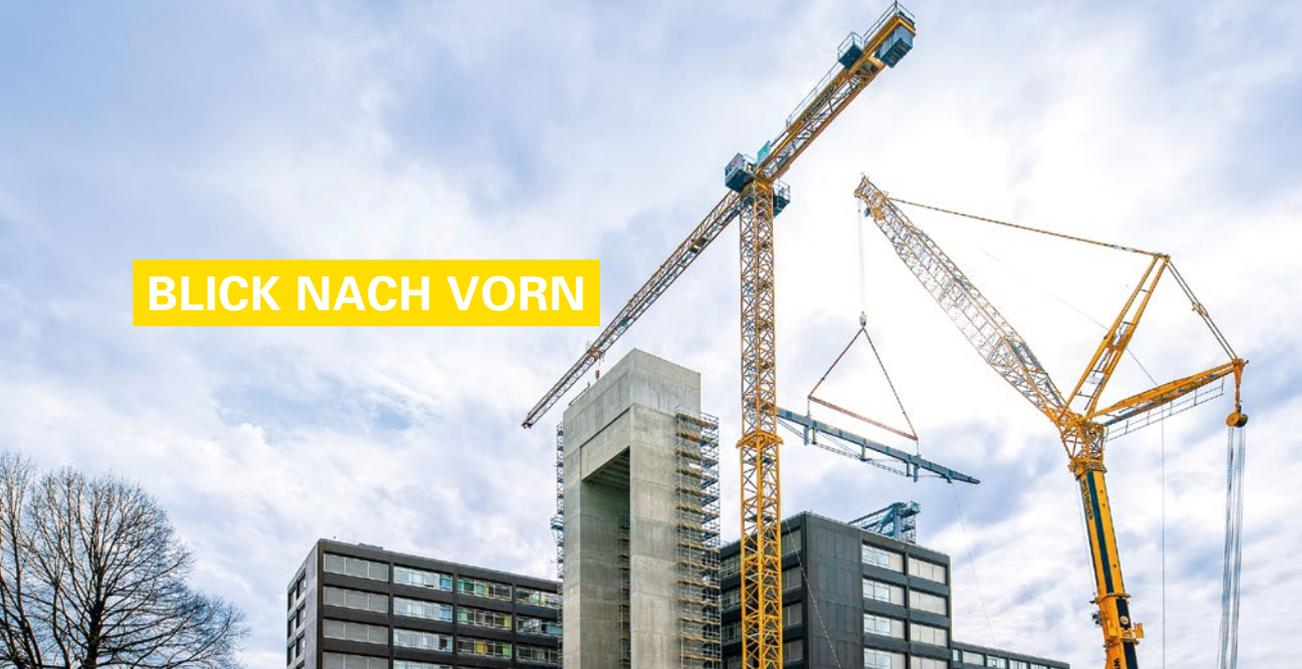
Neuer Hubschrauberlandeplatz auf dem Dach des Bundeswehrkrankenhauses Ulm – Montage der Stahl-Hauptträger.
