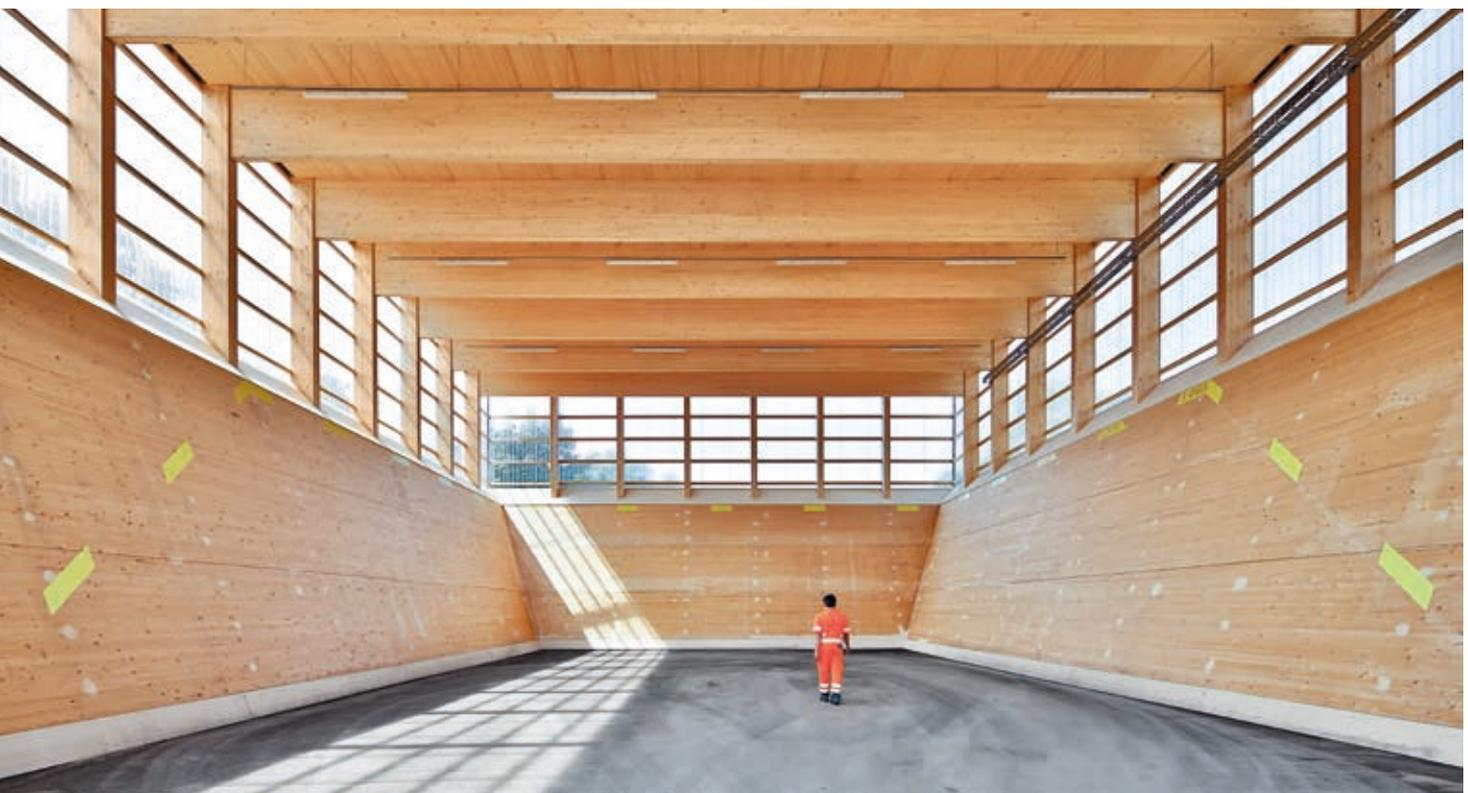
Die salzbeständigen, transparenten PVC-Wellplatten gewährleisten eine natürliche Belichtung im Innenraum, wo das Salz entlang der geneigten Schüttwände selbstständig nach unten rutschen kann.
