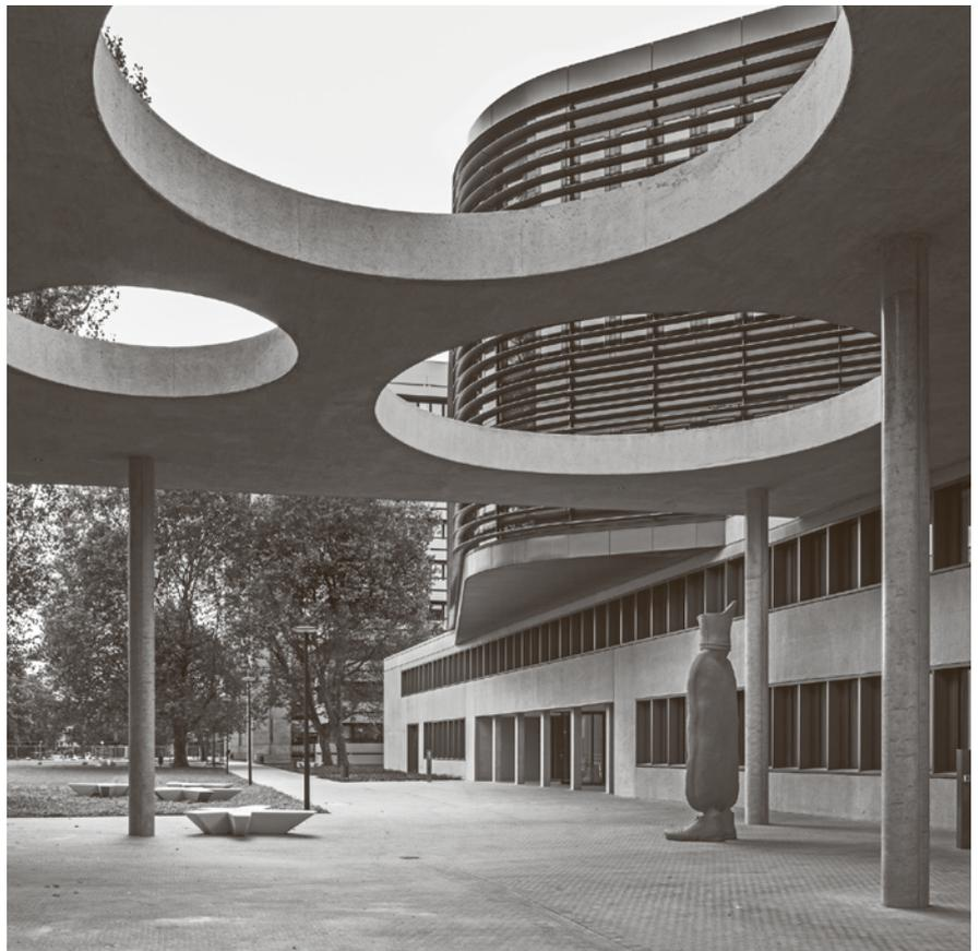
hend gläsernes Erscheinungsbild, das durch einen Screen aus feststehenden Aluminiumlamellen horizontal gegliedert wird. Die kupferfarbige Gestaltung der Traufkante und der überkragenden Deckenplatte des zweiten Obergeschosses unterstreicht die Horizontale zusätzlich und fasst die gläsernen Baukörper nach oben und unten. Der Farbton wird in den horizontalen Fensterbändern der beiden Sockelgeschosse und in den Treppenhäusern aufgegriffen.
