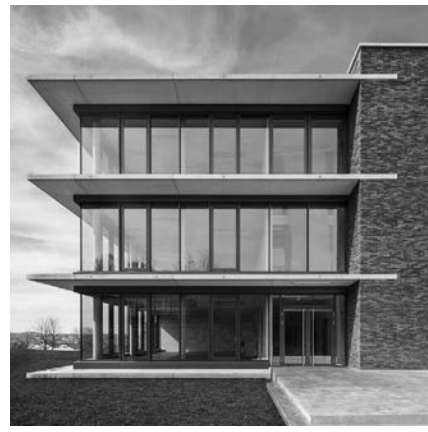
Haupteingang von Süden
