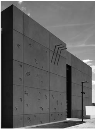
GEPLANT UND GEBAUT S. 14 Neubau einer Elementary und High School in der Panzerkaserne Böblingen
