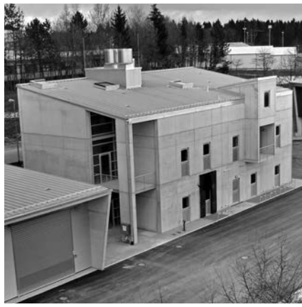
Brandübungshaus zur Simulation von Bränden in Gebäuden
